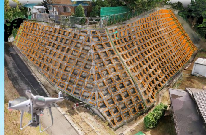
UAVを用いて撮影したデジタル画像から、空中三角測量や計測現場の3次元形状復元を行うことで、図面作成、土量計算、点検業務などが可能です。撮影から3次元形状復元までは最短1日で行う事が出来ます。災害現場等の迅速な状況把握が必要な現場での活用が可能になります。また、復元した地形データは3Dソフト上で解析、編集をすることができます。
